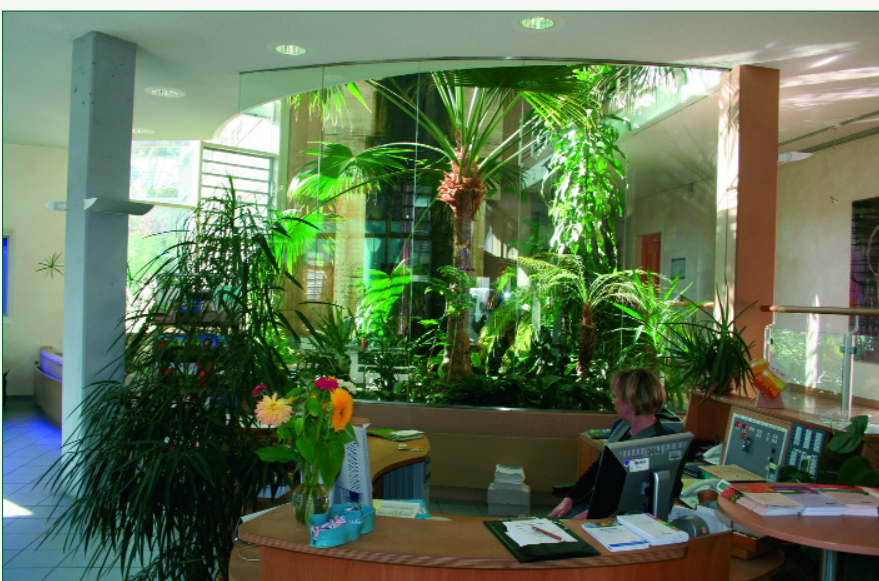
Abb. 5: Schön und praktisch zugleich: die ökologische Klimaanlage des Hauses
